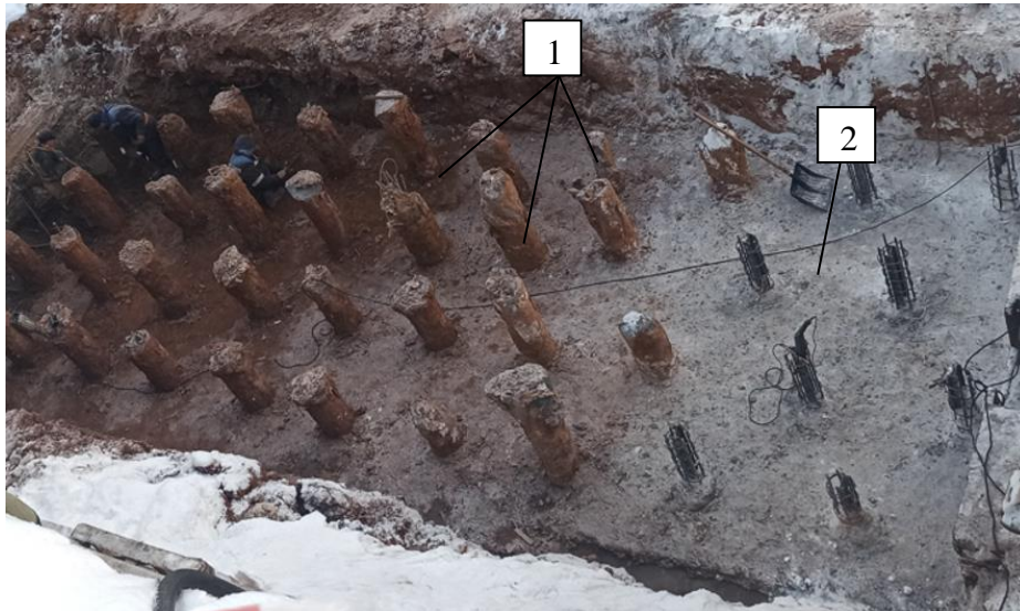
Рисунок 2. Свайное поле под монолитный железобетонный контрфорс: 1 – оголовки буронаблюдательных свай ЭРТ; 2 – бетонная подготовка под ростверк.
