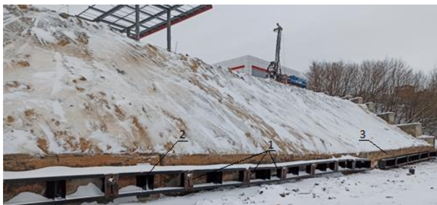
Рисунок 3 Фотография анкерного крепления деформированного откоса на оползневом склоне на абсолютной отм. 94.60: 1 — грунтовый анкер; 2 — анкерный обвязочный пояс; 3 — уголковые монолитные железобетонные подпорные стены.
