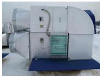
Рис.4. Общий вид вентиляционно-отопительного модуля системы
